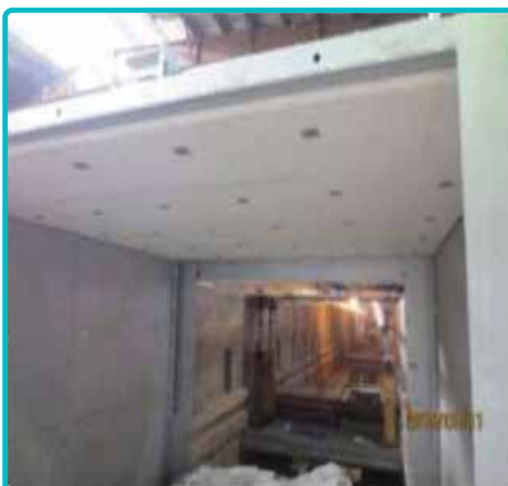
بدنه خشک‌کن که با استفاده از بردهای کلسیم سیلیکات پوشیده شده
