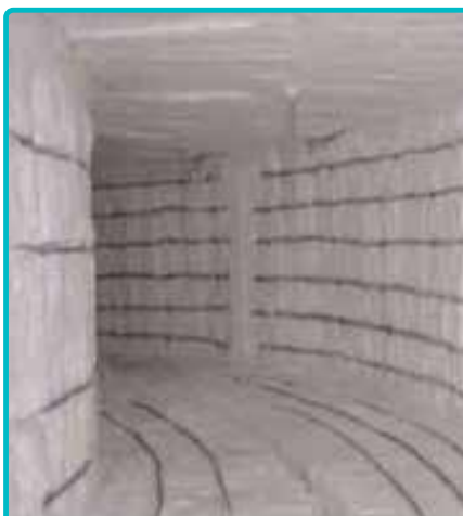
مجاری عبور گازهای حاصل از احتراق با استفاده از مدول
