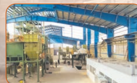
نصب تجهیزات سالن خردایش
