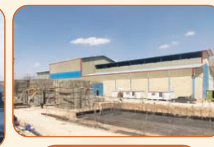
آرماتور بندی سازه کولر کوره دوار و بتن ریزی پایه‌های کوره دوار (۲)
