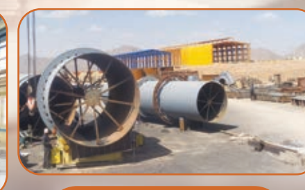
کارگاه تعمیرات شل‌های کوره دوار جهت نصب (۲)
