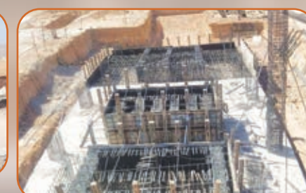
فونداسیون خنک‌کن کوره دوار ۱
