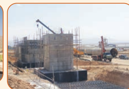
آرماتور بندی سازه تغذیه کوره دوار
