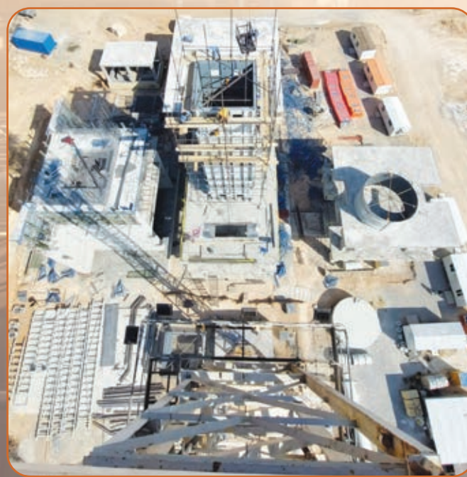
آماده‌سازی شل‌های کوره دوار جهت نصب
