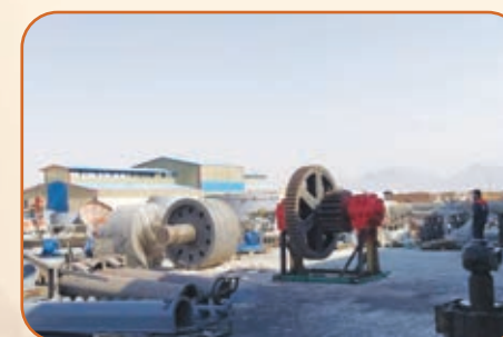
بازسازی و تعمیرات تجهیزات کوره ۱
