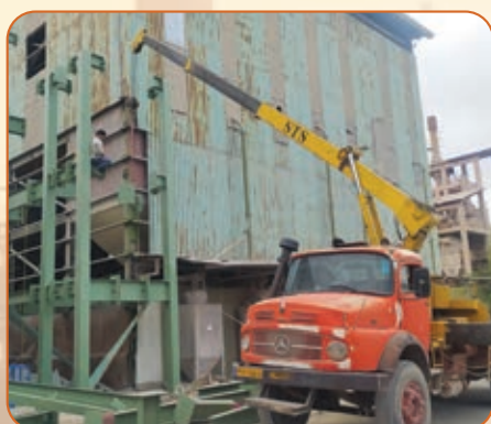
نصب سازه فلزی
