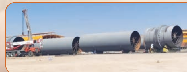
آماده‌سازی شل‌های کوره دوار جهت نصب
