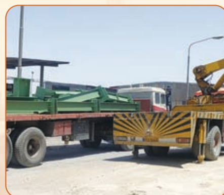
تخلیه سازه فلزی در محل پروژه
