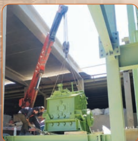
نصب آسیاب ضربه ای
