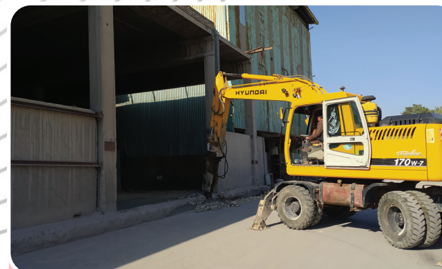
حفاری و تخریب
