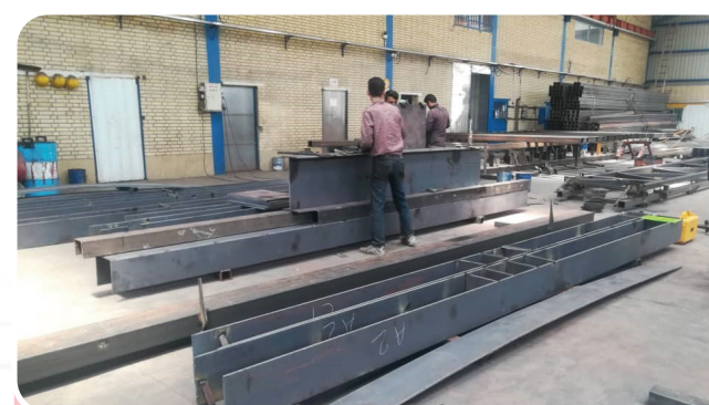
ساخت اسکلت فلزی
