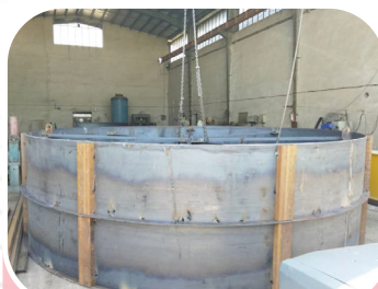
کارگاه‌های ساخت تجهیزات
