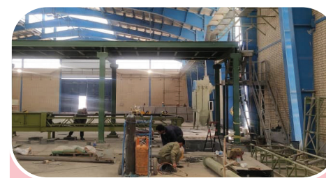
نصب نوار نقاله و تجهیزات سیستم توزین
