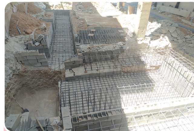
اجرای آرماتوربندی اسکلت فلزی
