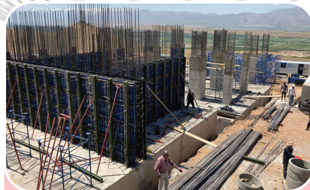
فونداسیون ناحیه خوراک دهی
