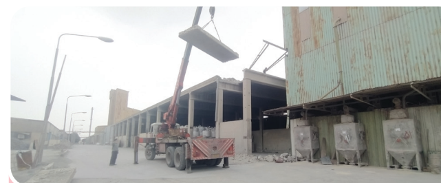
آماده سازی محل اجرای پروژه
