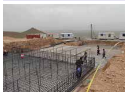
تجهیز کارگاه و حمل متریال و شروع عملیات اجرا
